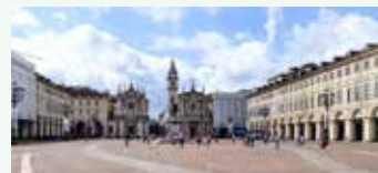
Centro storico di Torino
