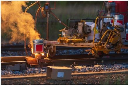
Abb. 120.1 „Schweißen“ von Schienen
