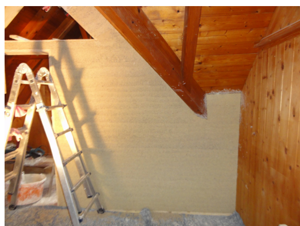
Abb. 66 – 67: Innenwand aus Hanfkalk
