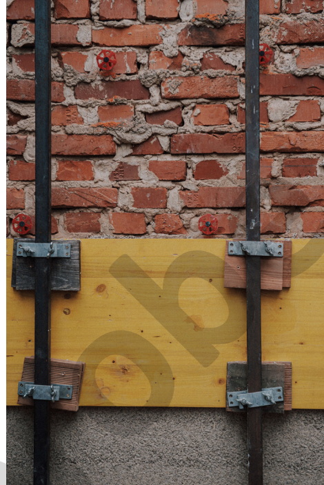
Abb. 63 – 65: Bestandssanierung mit Hanfkalk
