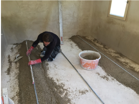
Abb. 70 – 72: Hanfkalk als Bodenaufbau
