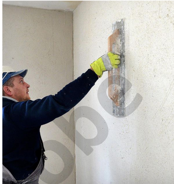
Abb. 68 – 69: Innenwand Verputzarbeiten
