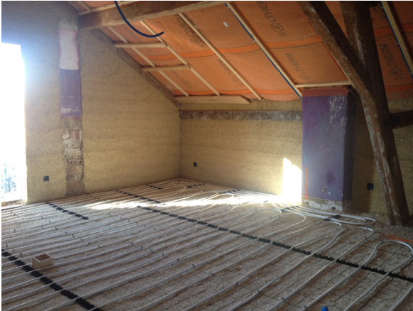
Abb. 54: Weiterer Bodenaufbau Holzbalkendecke
