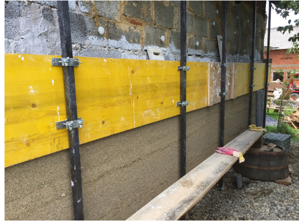
Abb. 55 – 58: Wandaufbau Hanfkalkbauweise
