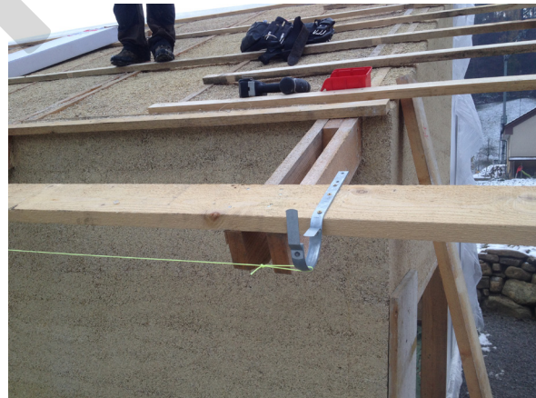
Abb. 50: Einbau des Hanfkalks
