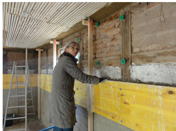
Abb. 59 – 62: Herstellung Hanfkalkwand
