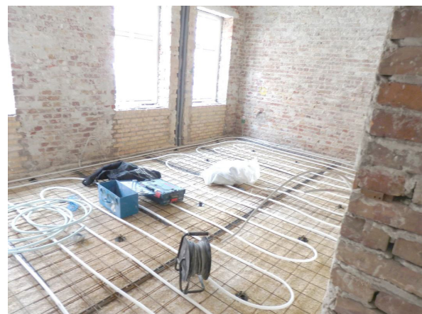
Abb. 73 – 76: Hanfkalk als Bodenaufbau
