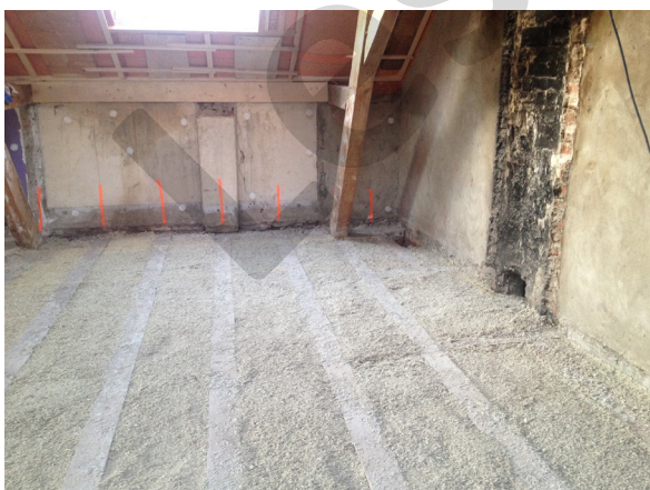
Abb. 53: Holzbalkendecke Zwischenisolation
