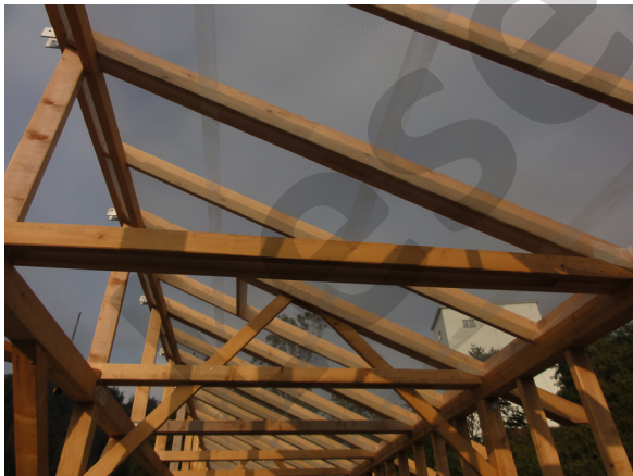
Abb. 49: Dachstuhl
