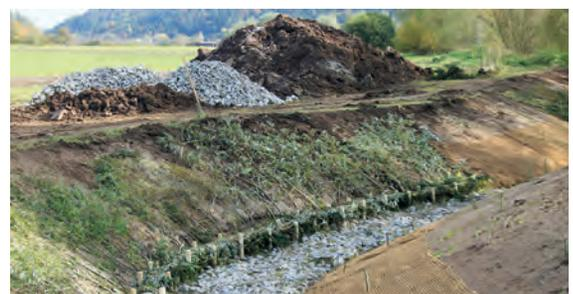
Böschungssicherung mit unterschiedlichen Baustoffen
