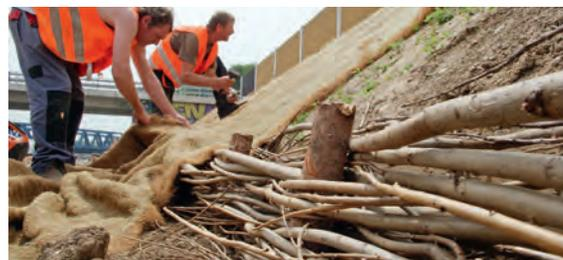
Böschungssicherung durch Flechtzäune und Saatmatten
