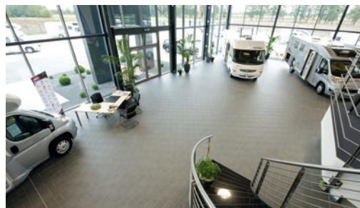
Rüttelverlegter keramischer Belag
