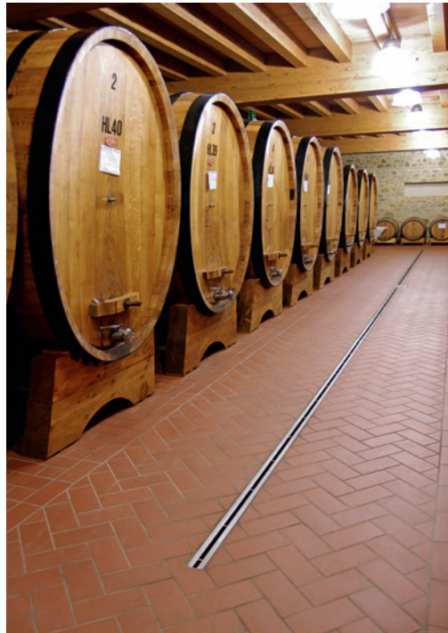
Verlegung im Fischgrätverband
