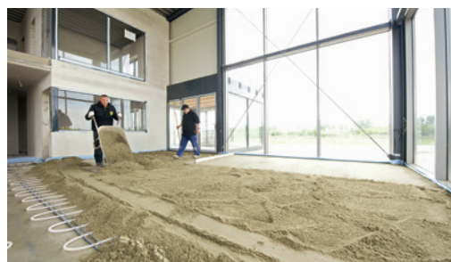
Einbringen und Verteilen des Mörtels
