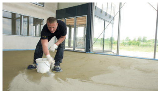
„Pudern“ des Verlegemörtels mit Zement
