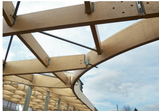
Kerto®: gebogene Binderkonstruktion
