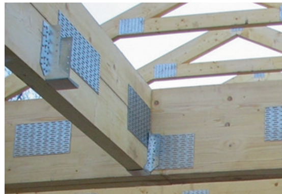
Nagelplatten-Balkenbinder
