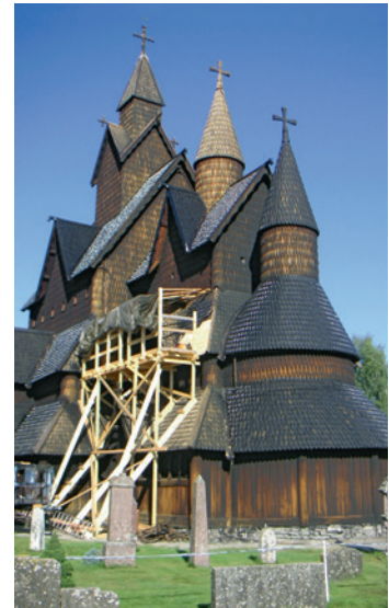
Die Heddal-Stabkirche in Norwegen, erbaut bereits um 1250 n. Chr. Bei Bedarf werden lediglich Dachschindeln ersetzt, um Feuchteschäden zu vermeiden
