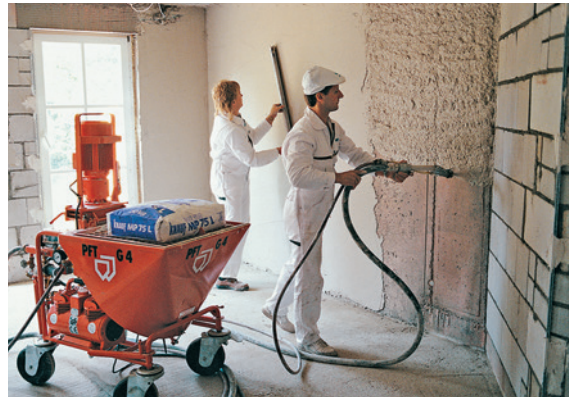
Aufbringen und Glätten eines Innenputzes
