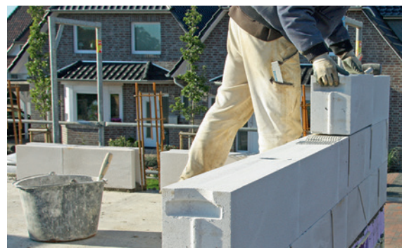
Versetzen von Porenbetonsteinen
