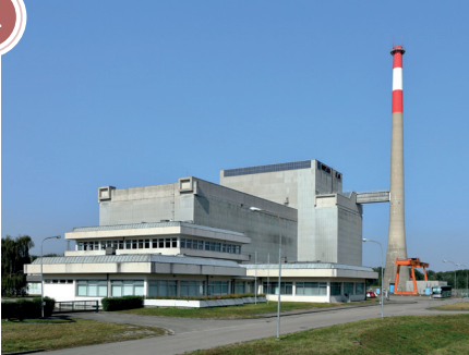
Kernkraftwerk Zwentendorf, Fotografie, 2018
