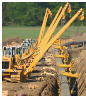
der Rohrleitungsbau l'installation de tuyaux budowa rurociągów f строительство трубопровода n
