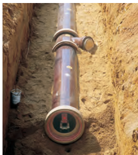
der Kanalbau la construction de canalisations budowa kanałów f строительство канализации n
