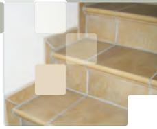
2. | Zwischen Erdgeschoss und Dachgeschoss soll die Treppe einen Belag aus blaugrau glasierten Spaltplatten erhalten. Der Sockel an Wand und gemauerter Brüstung ist abgestuft. Aus schallschutztechnischen Gründen ist der Belag schwimmend verlegt. Um einen besseren Eindruck der optischen Wirkung zu bekommen, wird eine Zeichnung von 7 Stufen in größerem Maßstab angefertigt.
