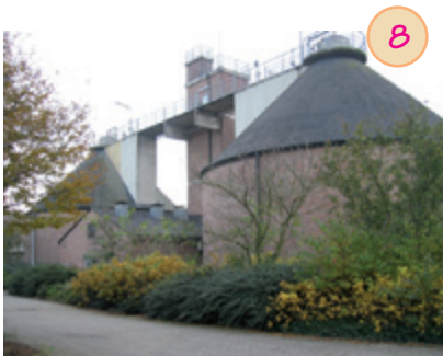
8 Faulurturm: Klärschlamm wird eingeleitet. Nach ca. drei Wochen ist Gas entstanden.
