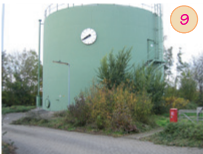
9 Gasbehälter: Hier wird das Klärgas gespeichert, um dann mit Gasmotoren Strom zu erzeugen.
