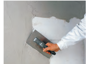
6. Abziehen der ersten Schicht
