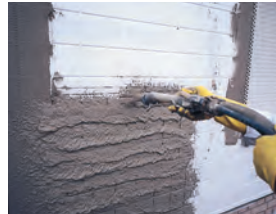
5. Aufspritzen des Armierungsputzes
