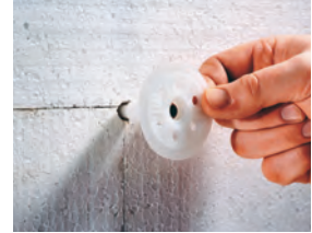
4. Dämmplatten verdübeln
