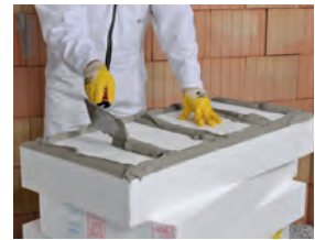
2. Klebemörtelauftrag
