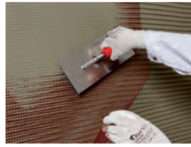
7. Einbetten des Armierungsgewebes
