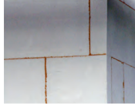
3. Dämmplatten im Verband verlegt
