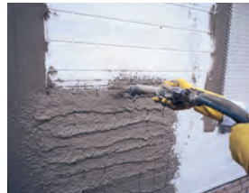
5. Aufspritzen des Armierungsputzes
