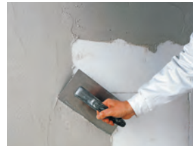
6. Abziehen der ersten Schicht
