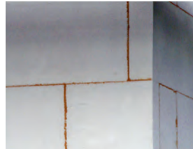
3. Dämmplatten im Verband verlegt
