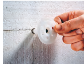
4. Dämmplatten verdübeln
