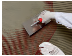
7. Einbetten des Armierungsgewebes
