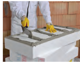
2. Klebemörtelauftrag
