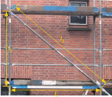
Gerüste erhalten Diagonalstreben zur Erhöhung der Steifigkeit. Wie groß muss der Bohrungsabstand in der Diagonalstrebe sein, wenn die Systemmaße des Gerüsts  $l_1 = 2,5$  m und  $l_2 = 2$  m betragen?
