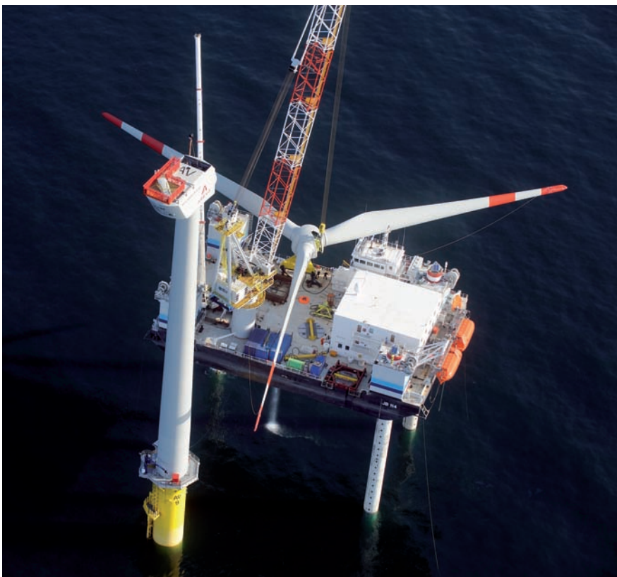
Abb. 6.1 ► Montage einer Windkraftanlage im Windpark Alpha Ventus
