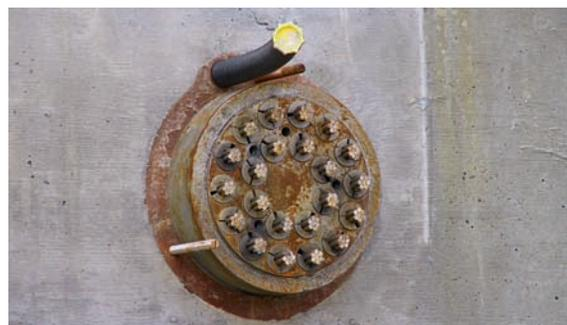
Gekürzte Spannlitzen befestigt mit einer Spannscheibe, gespannt mit Spannkeilen. Durch das schwarze Rohr wird der Zementmörtel eingepresst.
