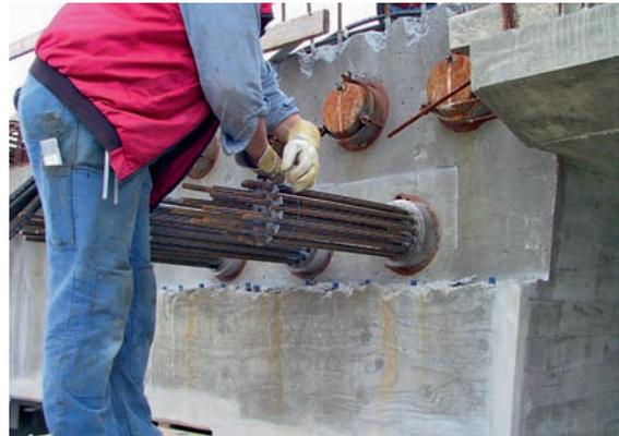
Spannlitzen mit Spannscheibe und Spannanker
