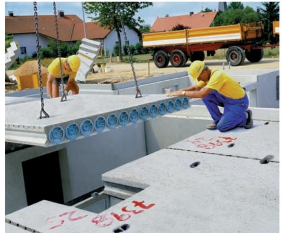
Verlegen von Hohlplatten mit V erschlusskappen aus Kunststoff
