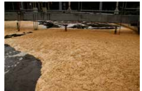
Abb. 87.2 Schaumbildung im Belebtschlammbecken einer Kläranlage
