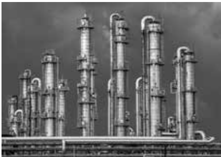
Abb. 101.1 Destillationskolonnen einer Raffinerie
