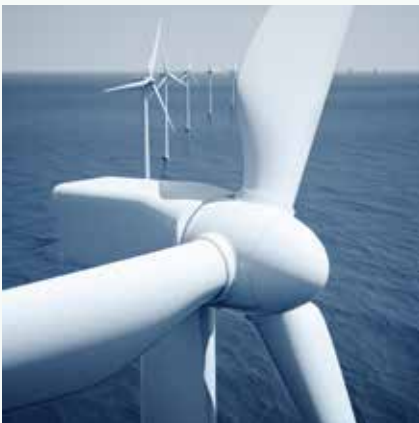
Abb. 10.2 Windkraftwerk: Bei modernen Windkraft-Anlagen wird die Winkelgeschwindigkeit des Rotors durch verstellbare Rotorblätter der Windgeschwindigkeit angepasst
