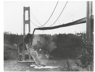
Abb. 2.15 Einsturz der Tacoma-Narrows-Brücke (1940)
